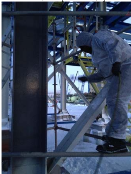
Рис.4. Нанесение Силотерм ЭП-6М на колонны эстакад НГХК, ноябрь 2012 г., при t = -17^{\circ}\text{C} .
